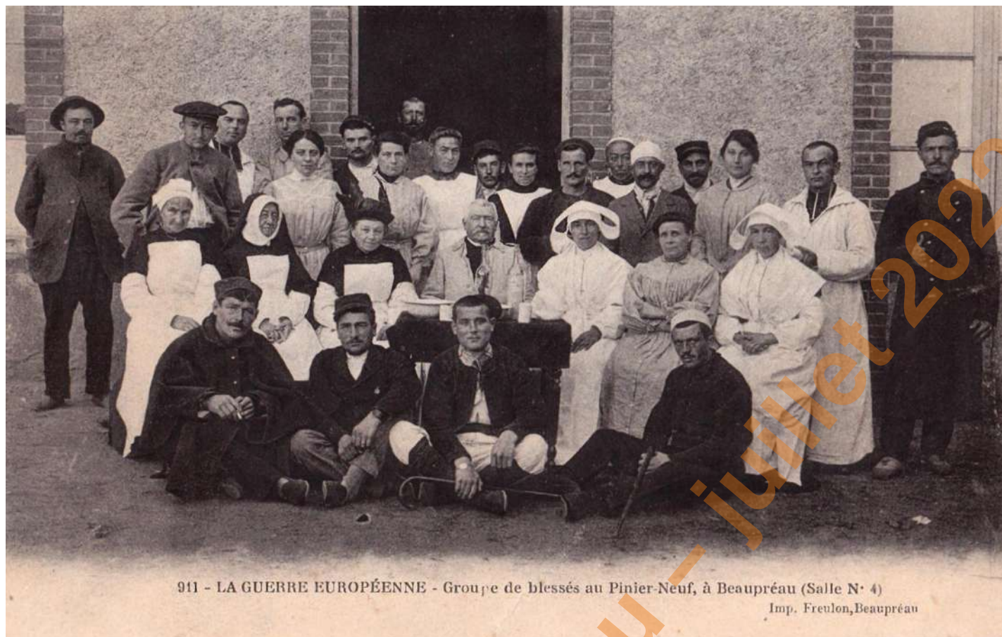
Un groupe de blessés et leurs soignants, médecins, infirmiers et infirmières, bénévoles, dans les bâtiments du "Pinier Neuf"
