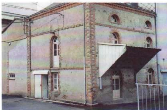
Bâtiments du moulin du Pont
