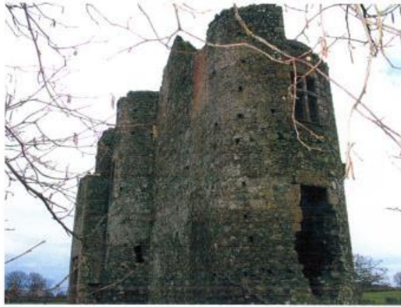
Les Hayes Gasselins : ruines.
