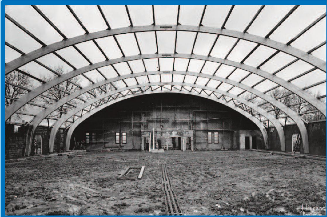
Le chantier début avril 1966... Sacha Distel s'annonce pour le 14 mai !
